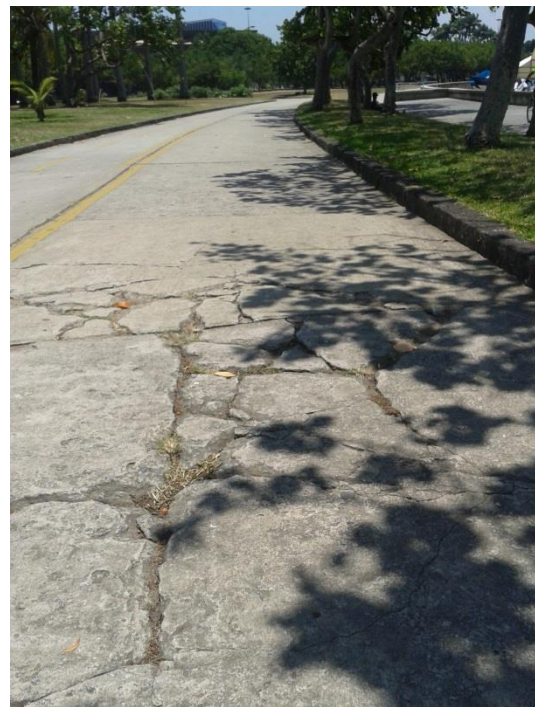
Figura 18 : Pavimento danificado Fonte: Autor (2014)
