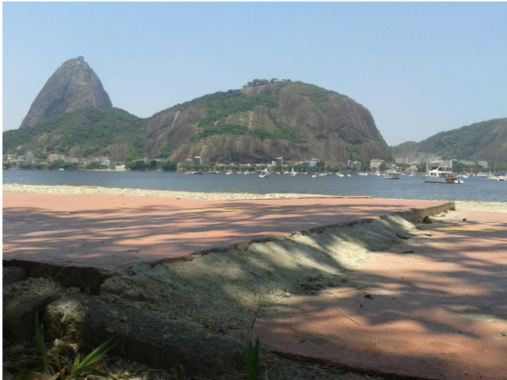
Figura 17: Desnível abrupto no pavimento Fonte: Autor (2014)
