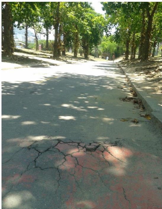
Figura 19: Asfalto danificado e desnivelado Fonte: Autor (2014)
