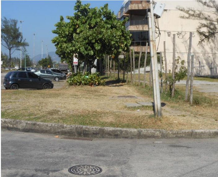
Figura 3-3: Calçada sem pavimentação. Fonte: Elaboração própria
