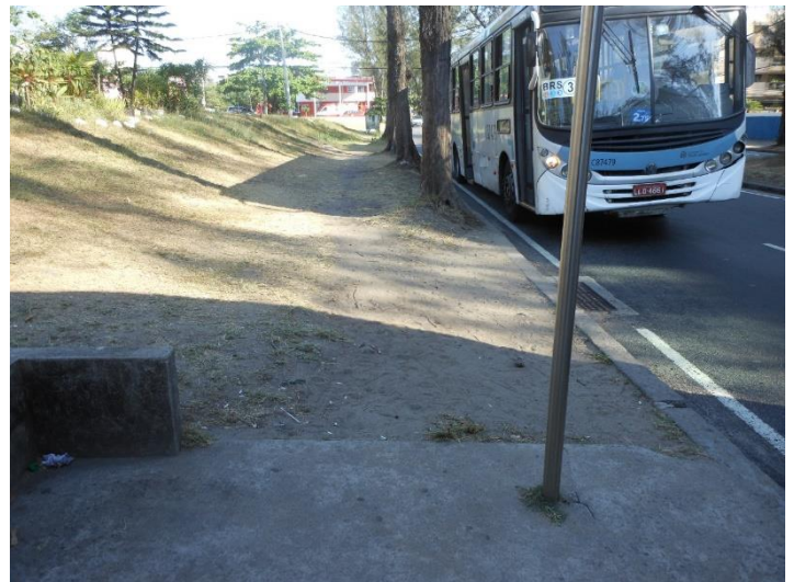
Figura 3-4: Calçada sem pavimentação no acesso ao ponto de ônibus. Fonte: Elaboração própria
