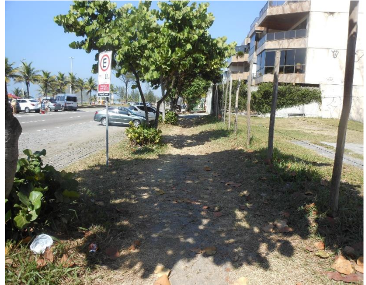
Figura 3-2: Calçada sem pavimentação. Fonte: Elaboração própria
