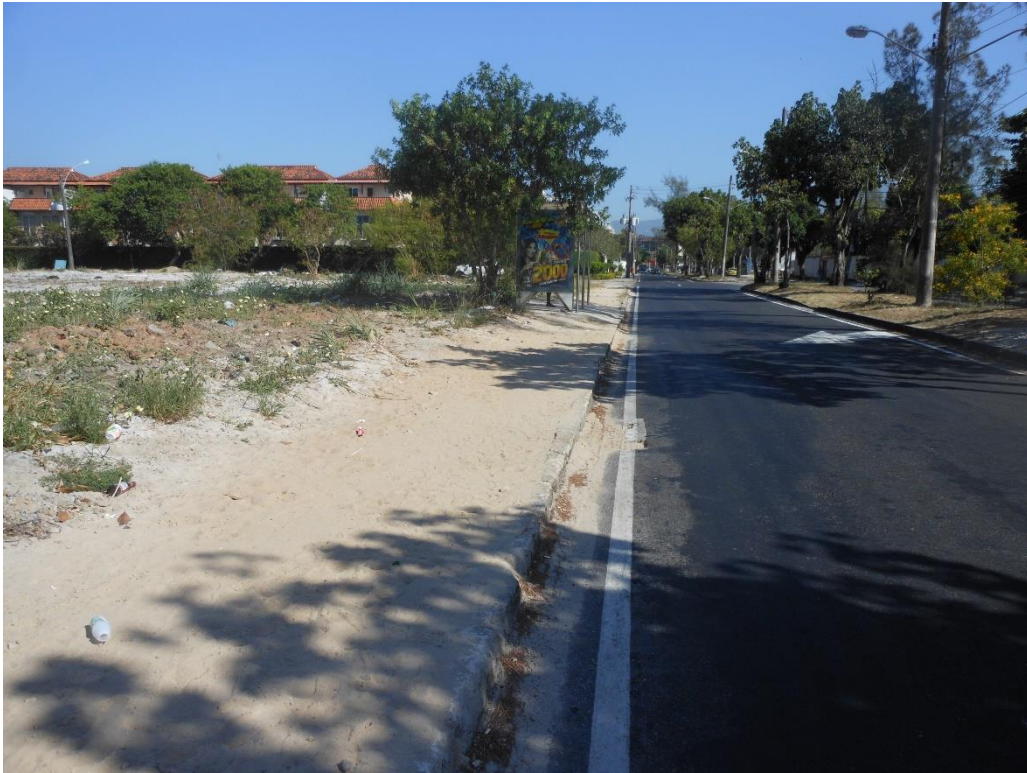
Figura 3-6: Calçada tomada por areia nos acessos ao ponto de ônibus.
