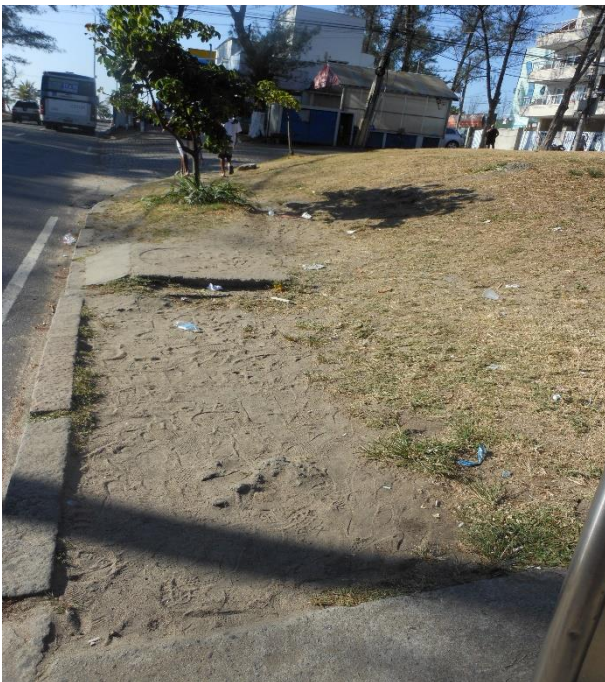
Figura 3-5: Calçada sem pavimentação no acesso ao ponto de ônibus. Fonte: Elaboração própria
