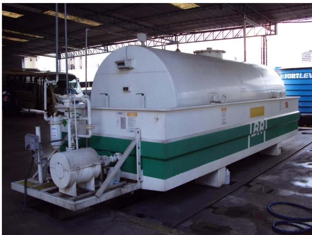
**Figura 23:** Tanque de abastecimento de AMD30.
