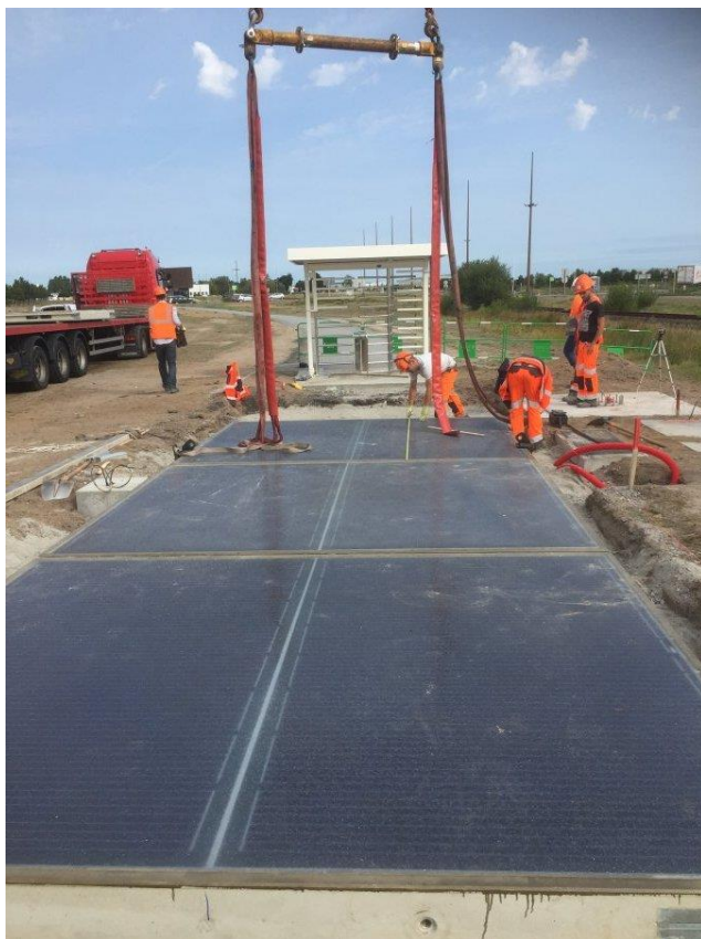
Figura 18 - Bloco pré-moldado para módulos FV, Frankrijk. Fonte: SolaRoad Frankrijk
